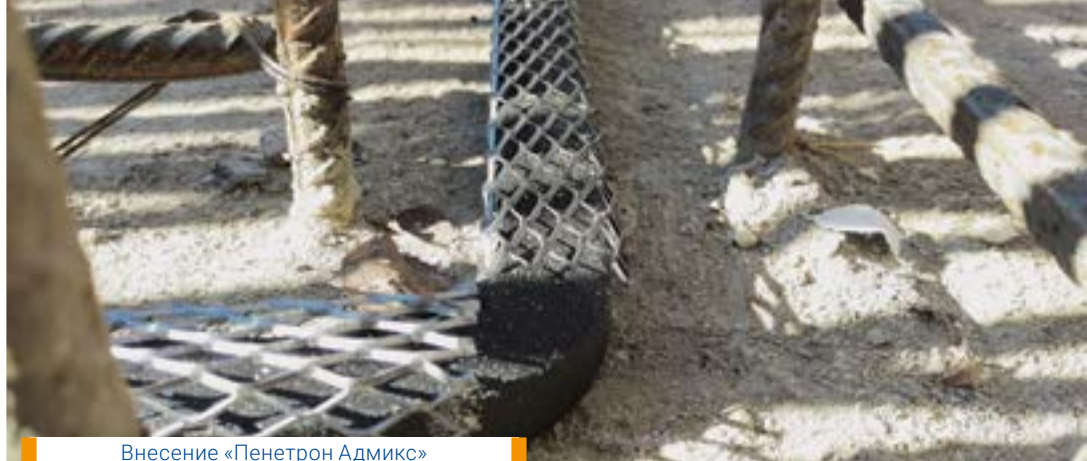
Внесение «Пенетрон Адмикс» в бетоносмеситель и монтаж «Пенебара»
