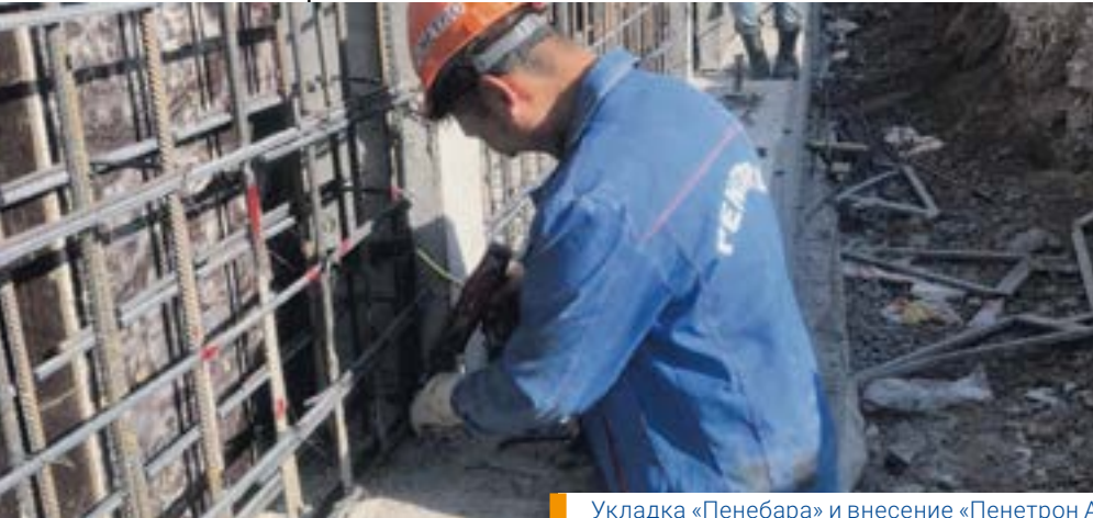
Укладка «Пенебара» и внесение «Пенетрон Адмикса» на объекте ТОО «Пенетрон-Казахстан»
