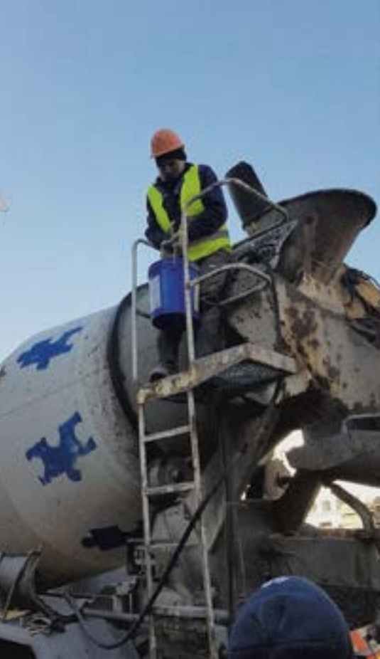
Внесение «Пенетрон Адмикс» в бетоносмеситель и монтаж «Пенебара»
